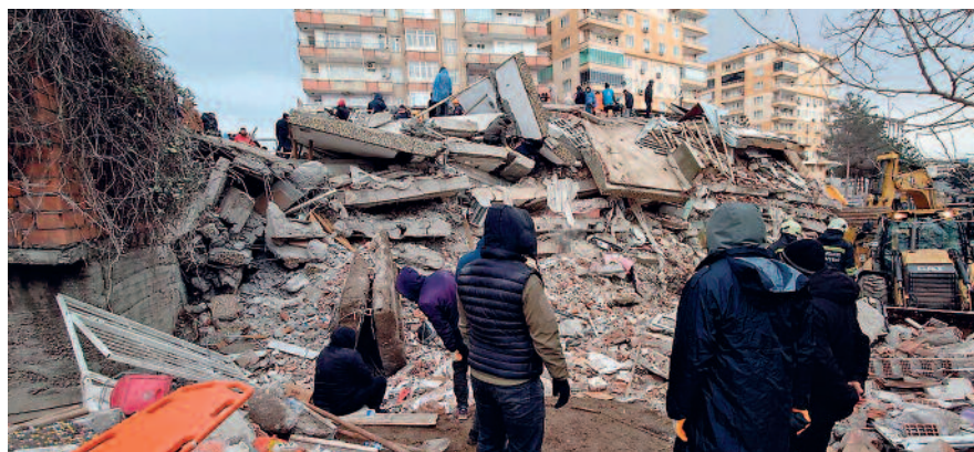
Eingestürztes Haus in Diyarbakir.
